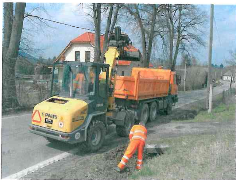
hloubení příkopů a úprava krajnic
