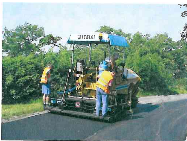
strojní pokládka živičných krytů
