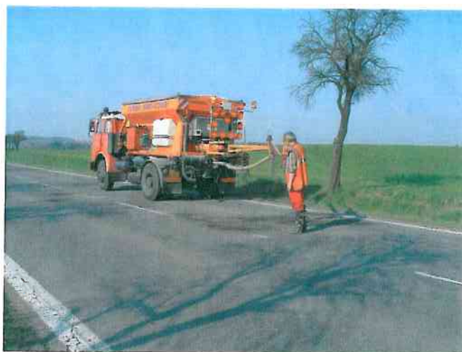
oprava výtluků tryskovou metodou-TURBO
